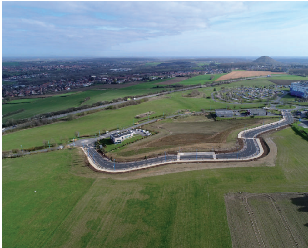
Une nouvelle voirie avec 9 parcelles vient d'être aménagée au pied de la polyclinique.
